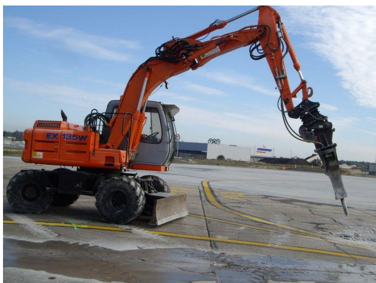
Photo 15 : Démolition au BRH
