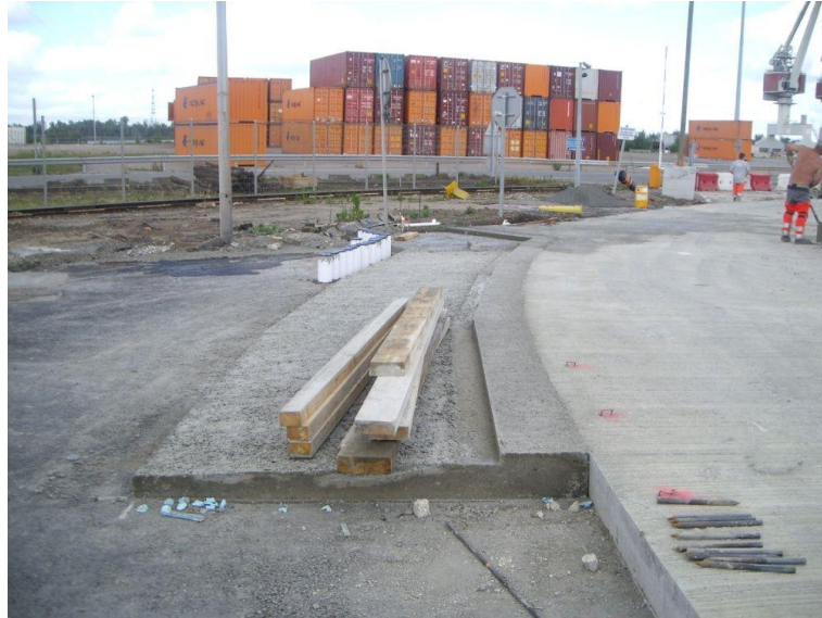
Photo 6 : Dalle de transition sur un giratoire (Crédit photo : CMR Exedra)
