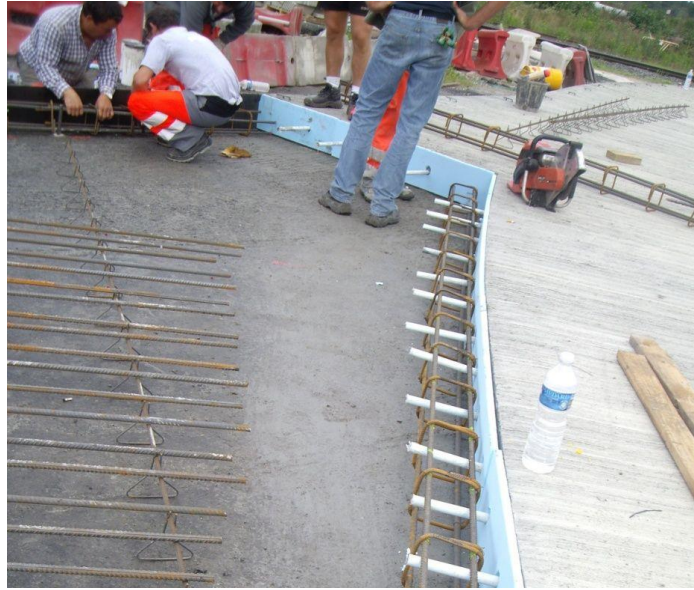
Photo 7 : Joint de dilatation avec goujons et chaînage (Crédit photo : CMR Exedra)
