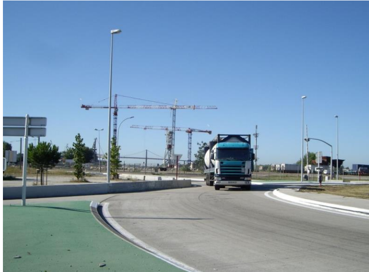
Photo 1 : Giratoire en béton armé continu (Z.I.P. BASSENS 33) (Crédit photo : CMR Exedra)
