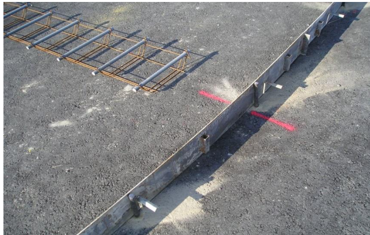
Photo 12 : Positionnement des paniers de goujons avant bétonnage du giratoire
