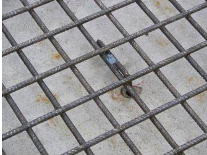
Photo 18 : Fixation du treillis soudé sur le support du BHP (Crédit photo : 11 ème Symposium Séville 2010)
