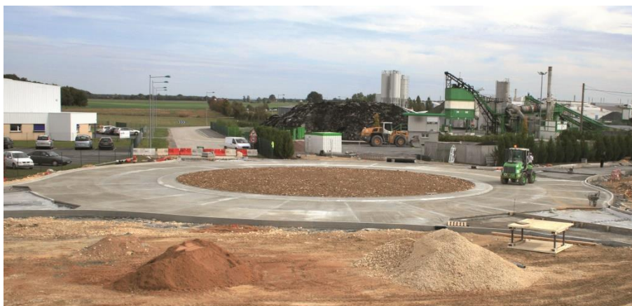
Photo 14 : Vue d'un giratoire en béton goujonné (Crédit photo : CIMBETON)
