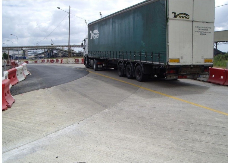
Photo 4 : Circulation pendant les travaux
