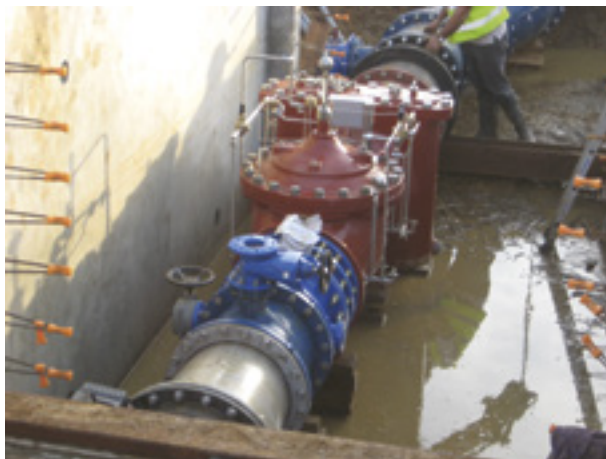
Figure 21 : Vanne de modulation de pression DN 500 mm (Suez)
