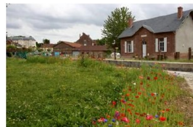
Maison éclusière de Long
