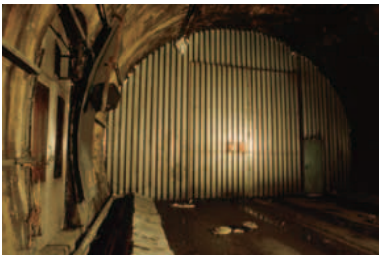
Photo 7 Séparation des deux parties du tunnel pour le génie civil
