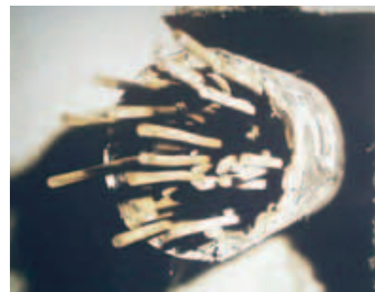
Photo 3 Rupture des fils du câble D5 Broken strands of cable D5
