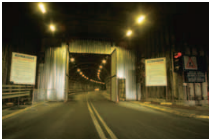
Photo 2 L'entrée du chantier Entrance to worksite
