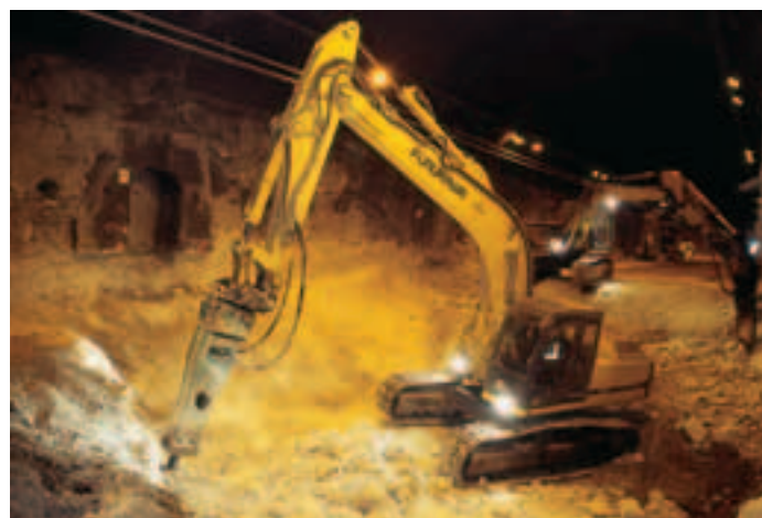
Contre-voûte. Déblai Inverted arch. Cuttings
