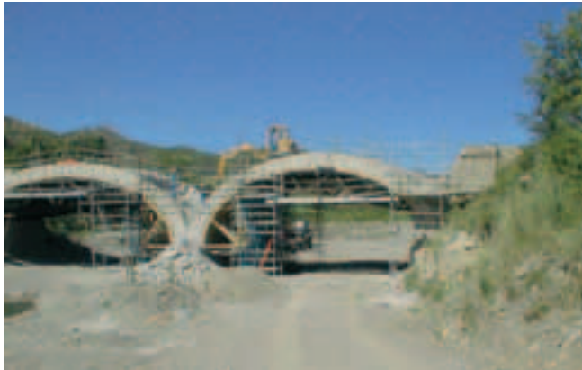
Photo 8 Démolition des tympans des voûtes V1 et V2 Demolition of spandrels on arches V1 and V2
