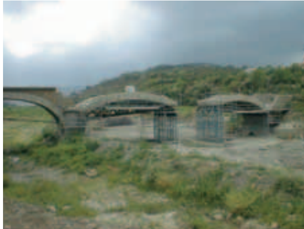
Photo 7 Pile P1 démolie Pier P1 demolished
