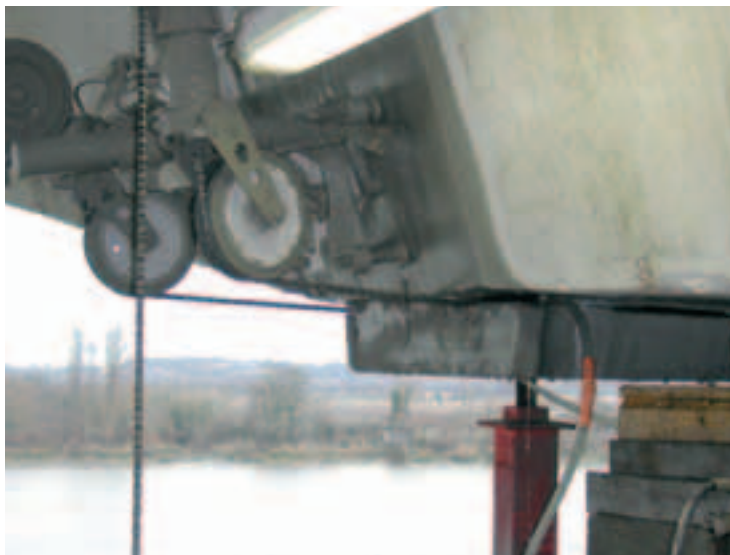
Photo 4 Sciage au fil d'un dé d'appui du viaduc principal Wire sawing of main viaduct foundation block
