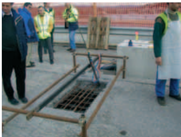
Photo 14 Intérieur du caisson après coupe des câbles Inside of caisson after cutting of cables
