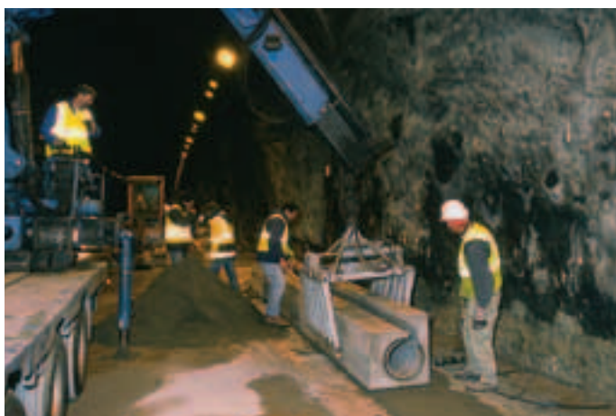
Pose du caniveau Satujo Placing the Satujo gutter
