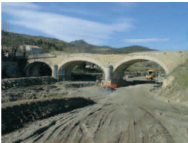
Photo 1 Pont de Durban après intempéries et avant travaux Durban bridge after storm and before works
