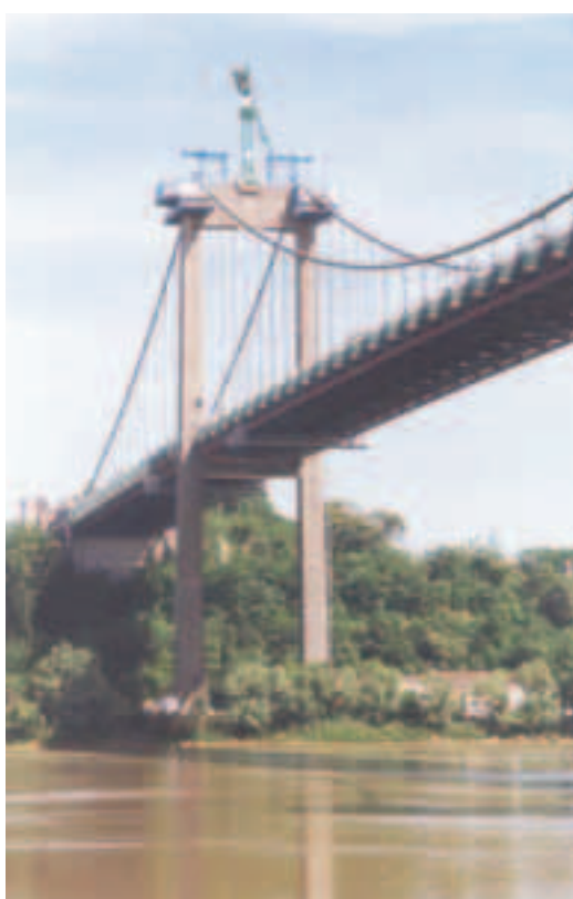
Photo 2 Vue du pylône depuis la berge View of tower from bank
