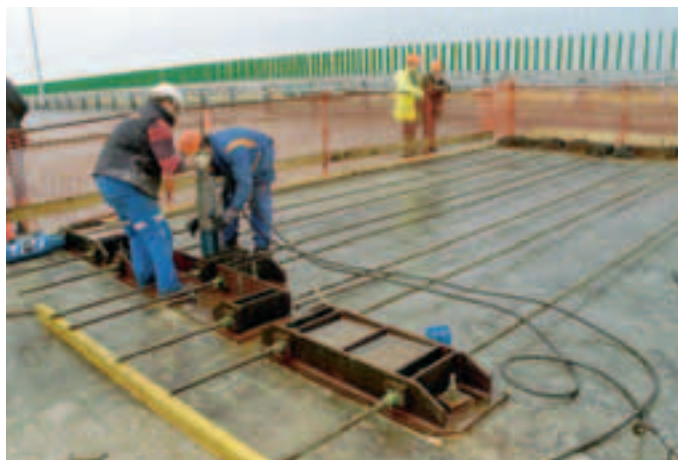
Photo 3 Renforcement transversal du hourdis supérieur des VSP et V1 des viaducs d'accès en phase de vérinage
