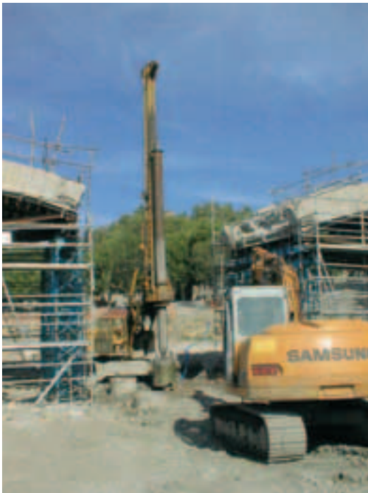
Photo 11 Exécution des pieux pile P1 Piling works on pier P1
