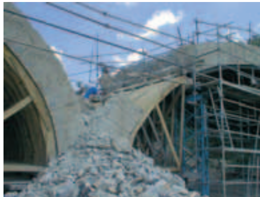
Photo 9 Démolition des naissances de voûtes V1 et V2 Demolition of springs on arches V1 and V2
