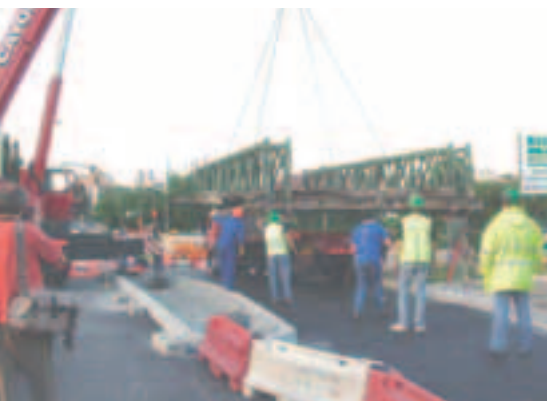
Dépose du tablier Bailey
