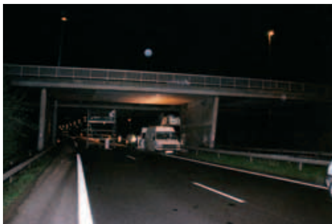
Photo 2 Intervention de nuit pour le renforcement en sous-face du tablier Night works on the deck underside
