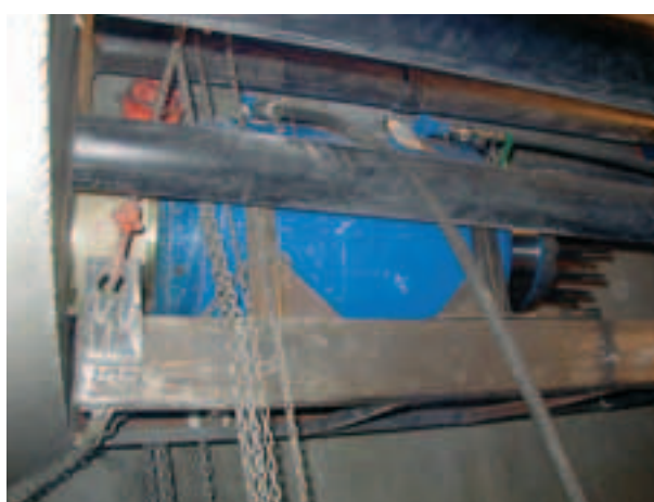
Photo 16 Difficile positionnement du vérin au milieu des câbles Difficult positioning of jack in middle of cables
