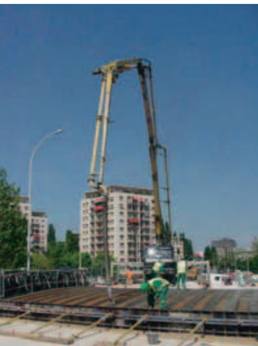
Bétonnage du tablier à poutrelles enrobées Concreting of coated-joist deck
