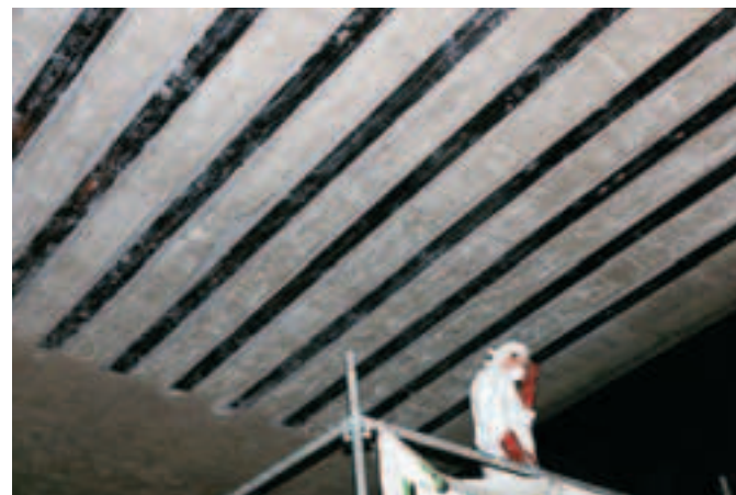
Photo 3 Vue du renforcement en sous-face par lamelles Sika Carbodur
