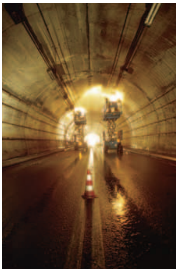
Photo 5 Le rétablissement des réseaux Restoral of networks
