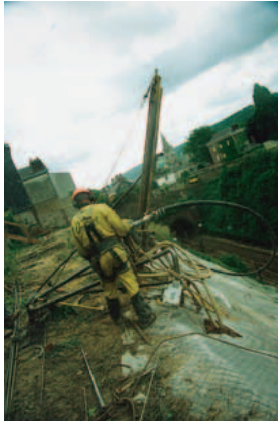
Détail de la rampe de forage adaptée au travail en milieu naturel subvertical
