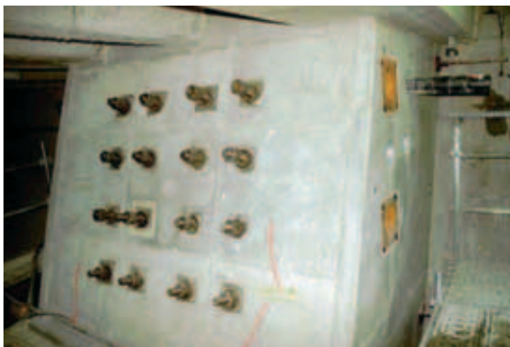
Photo 5 Massif d'ancrage de la précontrainte additionnelle sur viaduc principal, avant mise en tension des tiges de clouage
