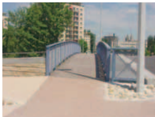
Détail de la passerelle avec platelage en azobé
