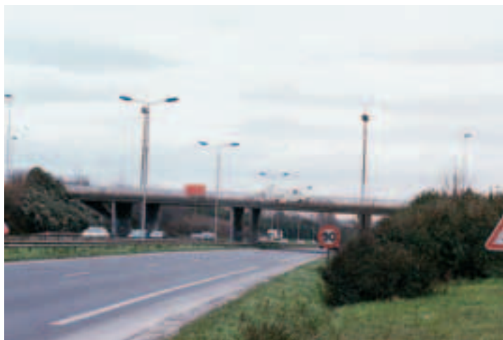
Photo 1 Vue générale de l'ouvrage au-dessus du périphérique General view of structure over the ring road
