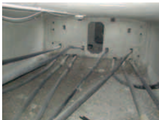
Photo 14 Intérieur du caisson après coupe des câbles Inside of caisson after cutting of cables
