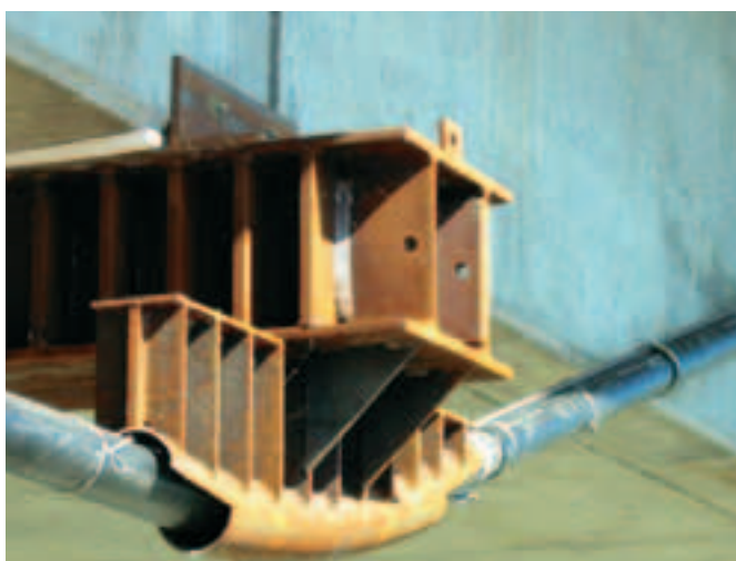
Photo 12 Détail de la selle d'appui en sous-face du caisson Detail of bearing saddle caisson underside
