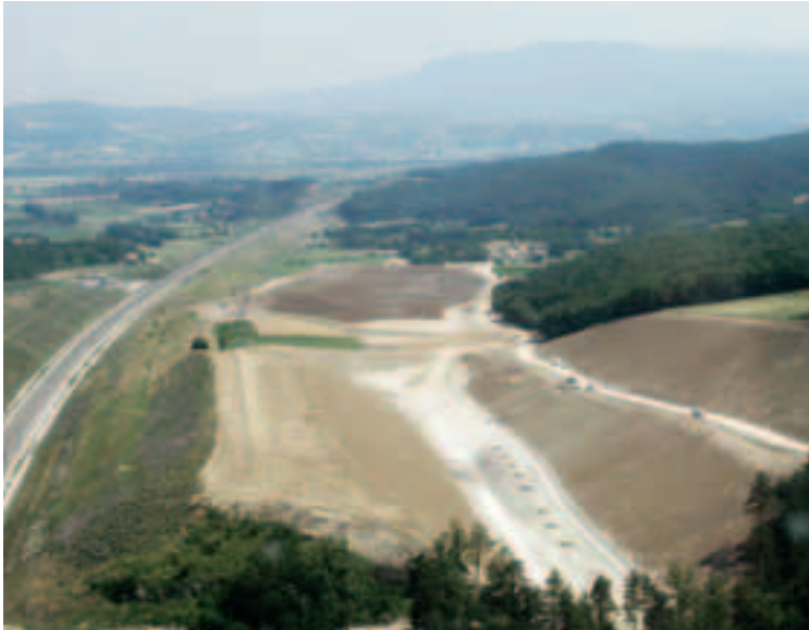
Photo 4 Chantier terminé. Au fond : le dépôt. Sur la droite : le rétablissement du "chemin des limites" (sur la risberme). Sur la gauche : le merlon laissé en place
