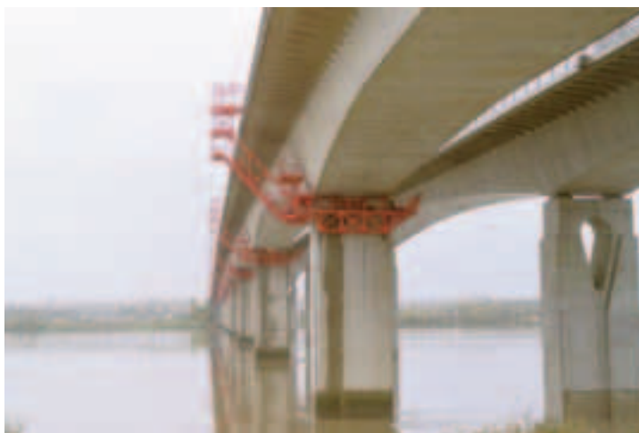
Photo 1 Vue d'ensemble de l'ancien viaduc (à gauche) avec les passerelles d'accès aux têtes de pile et du viaduc de doublement
