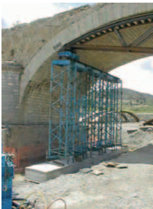
Photo 4 Pose du cintre sur palées provisoires
