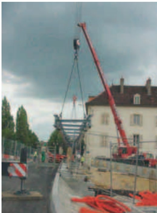
Livraison de la passerelle métallique Delivery of steel walkway
