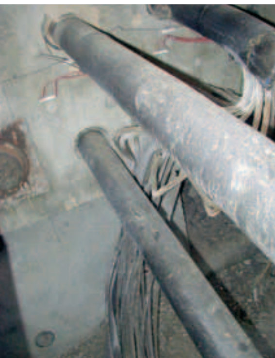
Photo 8 Dispositif d'alarme Alarm device
