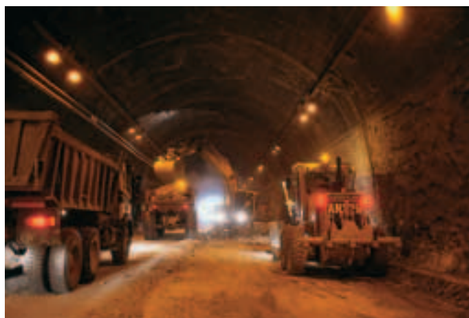
Alésage à la niveleuse Reaming with grader
