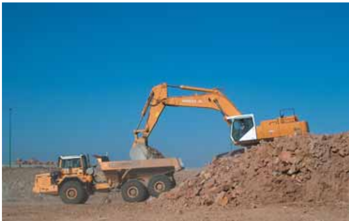
Déblai de La Guide La Guide excavation
