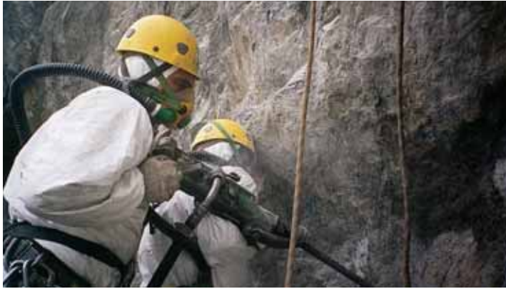
Techniciens effectuant un forage manuel pour mise en place d'ancrage de maintien du grillage Technicians performing manual drilling to install a grating fastening system
