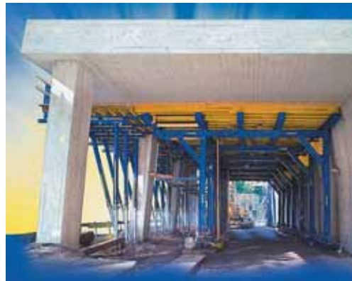
Doka: l'étalement SL-1 reprend des charges extrêmes
