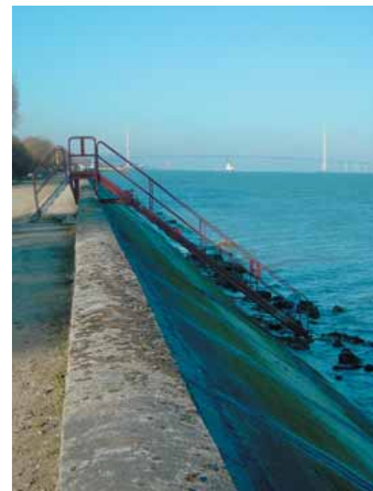
Photo 1 Passerelle d'accès aux berges Foot bridge for access to the banks
