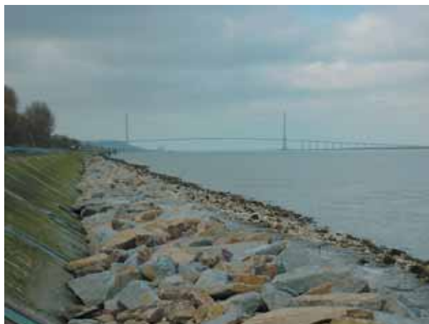
Photo 5 Enrochements mis en place Riprap in place
