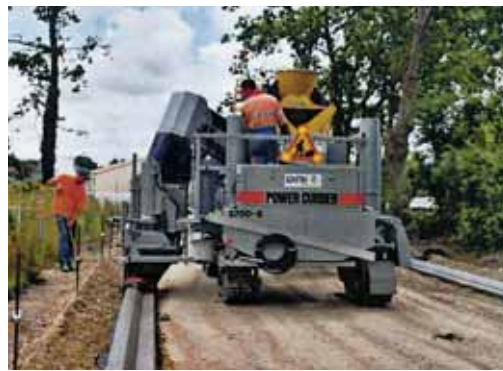
Cogeprec - Power-Curbers : machine à coffrage glissant
