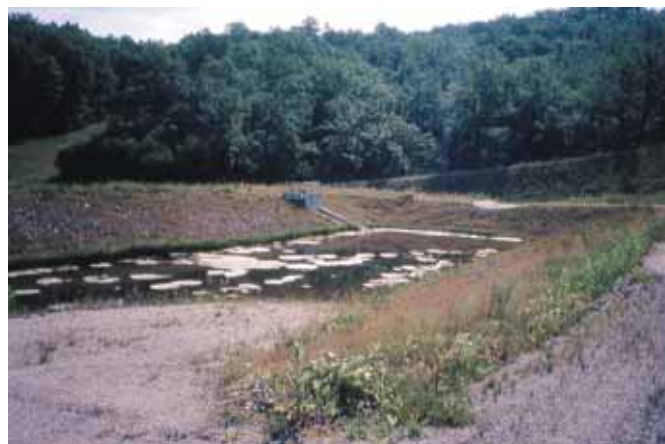
Photo 2 Bassin autoroutier sur A20 Motorway pond on A20
