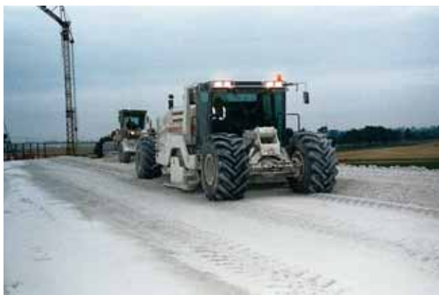
Malaxeur Racco 550 servant au traitement des PST
