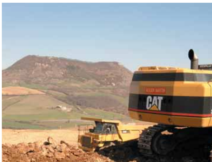
Point de vue depuis le déblai principal Viewpoint from the main earth cut
