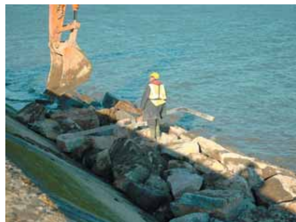
Photo 6 Gabarit pour la mise en place
