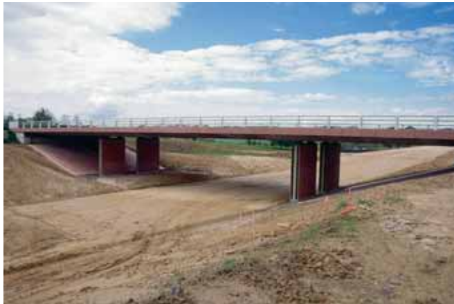
Application de la couche de forme par Axima Centre Application of the capping layer by Axima Centre
