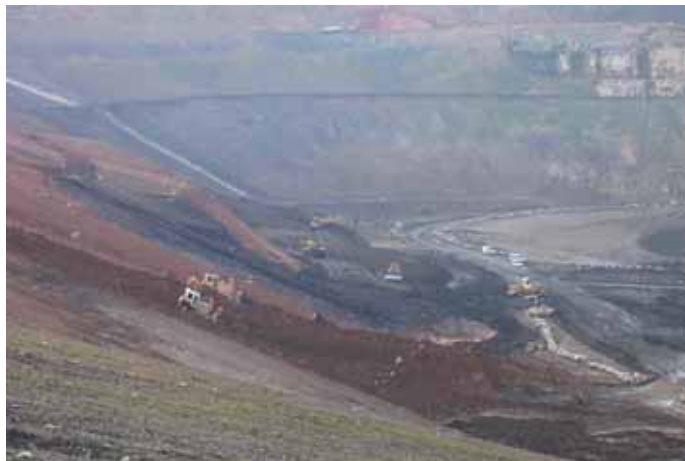
Terrassements piste de ski Earthworks for the ski run
