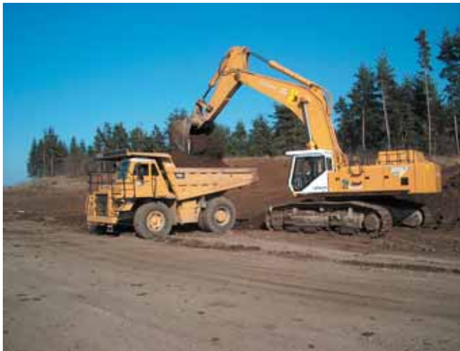
Déblai des Barrys Barrys excavation
