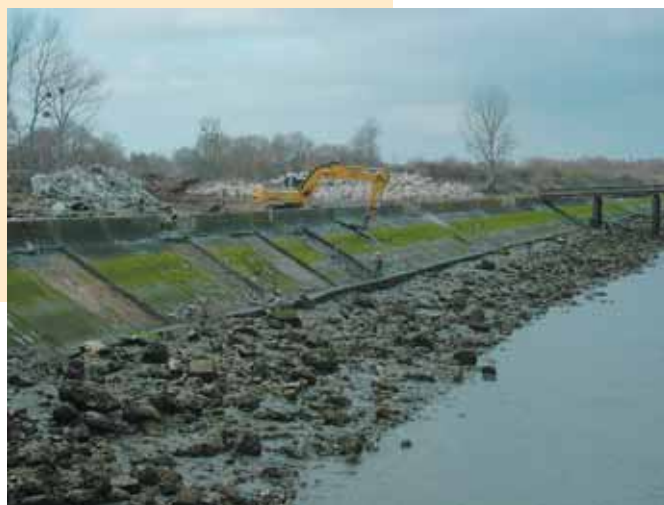
Photo 5 Enrochements mis en place Riprap in place
