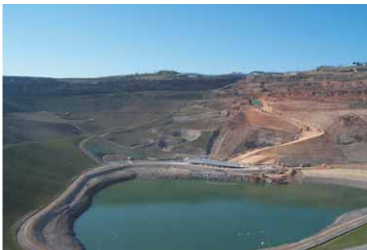
Vue globale sur terrassements grandes pentes
