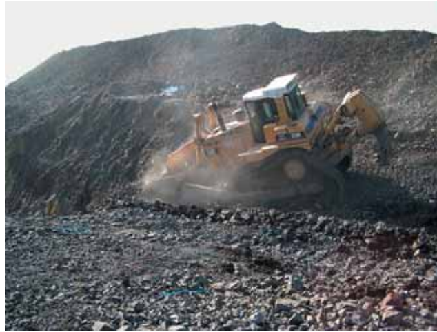
Déblai des Barrys Barrys excavation
