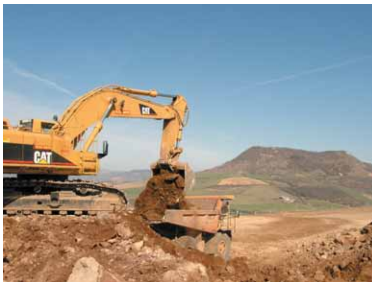
Extraction du déblai principal Extraction of main earth cuts
