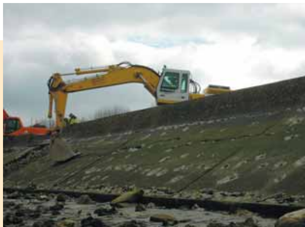
Photos 2, 3 et 4 Destruction des dalles et évacuation des gravats
