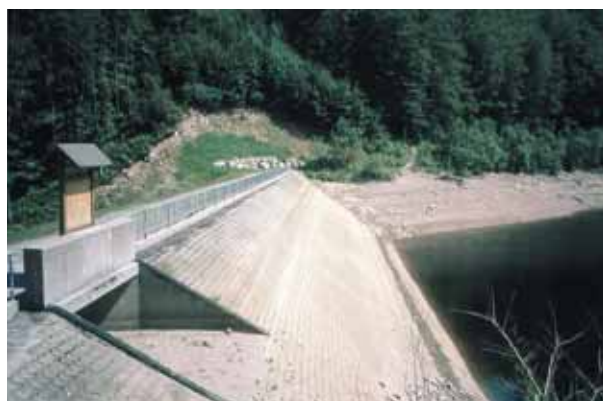
Photo 3 Barrage de la Lande (Vosges) La Lande dam (Vosges mountains)
