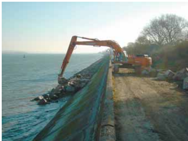
Photo 7 Mise en place des blocs Block laying
