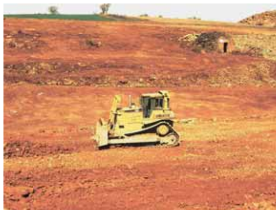
Première couche de remblai dans le vallon de Saint-Germain First layer of backfill in St Germain dale
