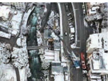
Passerelle piétonne de Brides-les-Bains récompensée dans le cadre des Trophées Eiffel.
