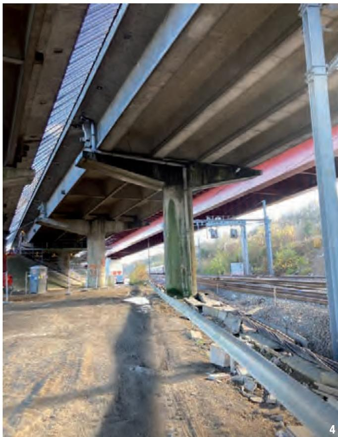
tion sur ces cachetages a montré que ces fissures restaient en surface, que le béton sous-jacent était sain et que les ancrages ne présentaient pas de corrosion importante. Le traitement est resté local en dégageant les parties non saines et en injectant la fissure liée à la reprise de bétonnage.
