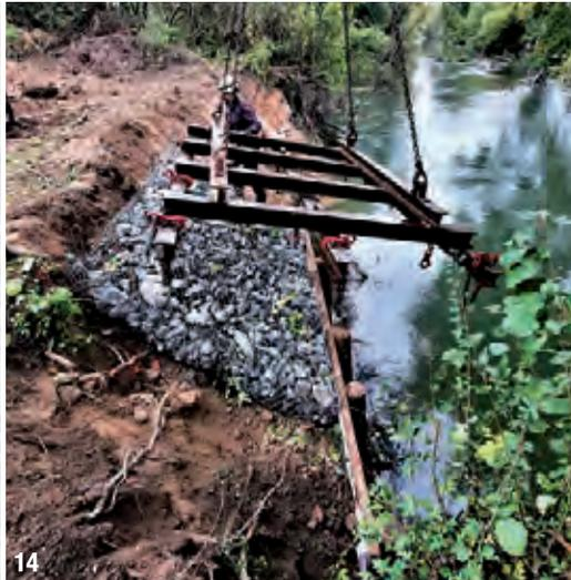
13 et 14- L'un des chantiers pour GRT Gaz en bordure de rivière, avant et pendant les travaux avec mise en place de gabions.
