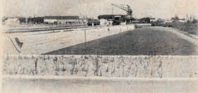
Fig. 8. — Le nouveau bassin et le quai ouest vus de la route en arrière du perré sud.
