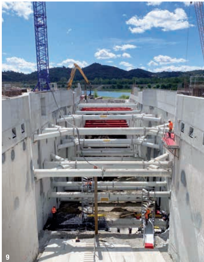
9- Vue des butonnages. © SPIE BATIGNOLLES FONDATIONS
