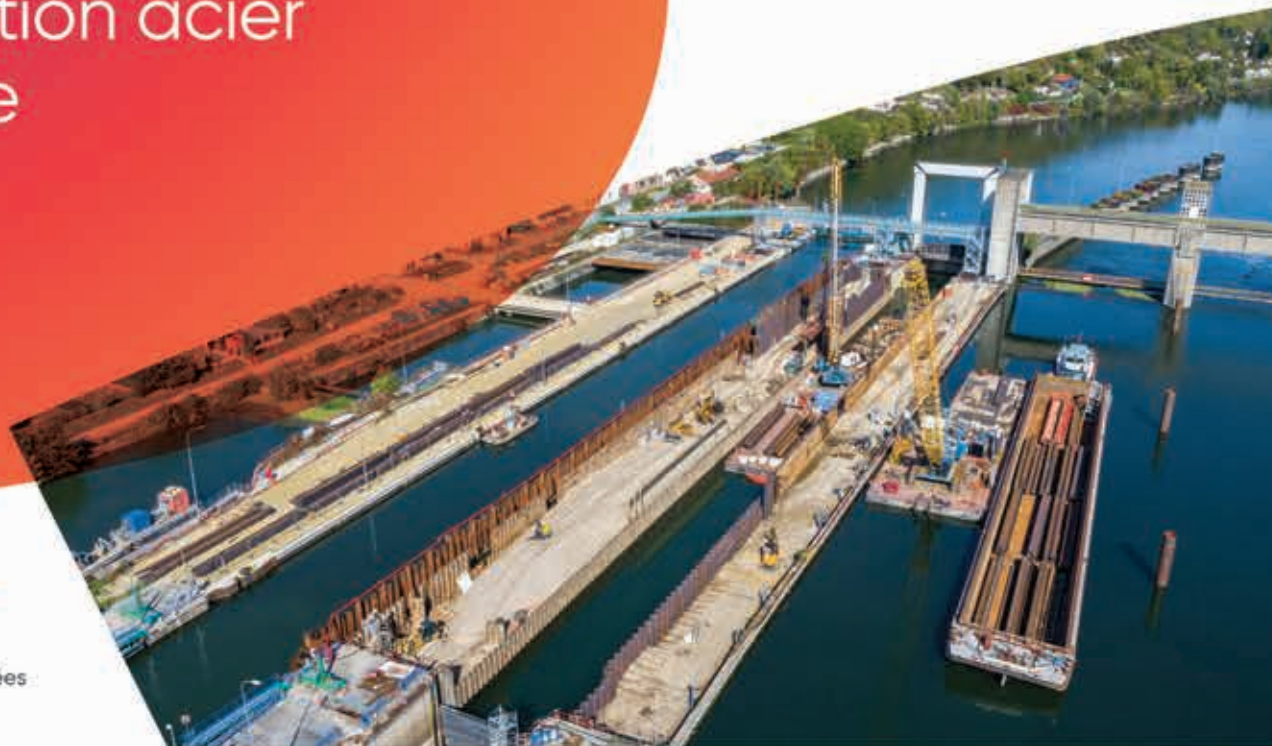
Rénovation des écluses de Méricourt sur la Seine © Bouygues Travaux Publics
