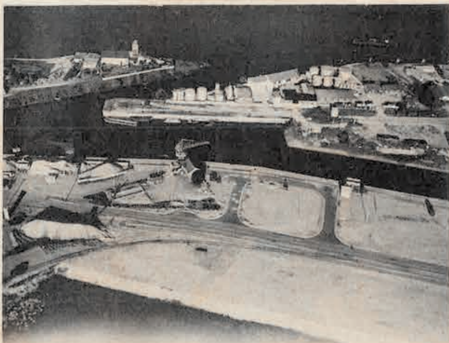
Fig. 6. — Vue aérienne du port de Mâcon au moment des derniers travaux d'aménagement des terre-pleins du quai ouest. Au fond : la Saône.
