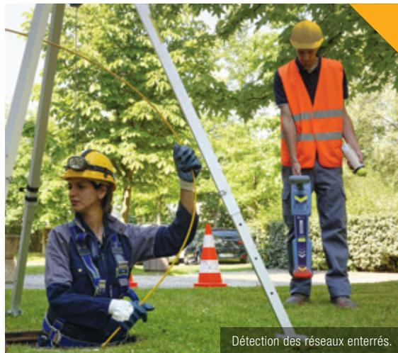
Détection des réseaux enterrés.
